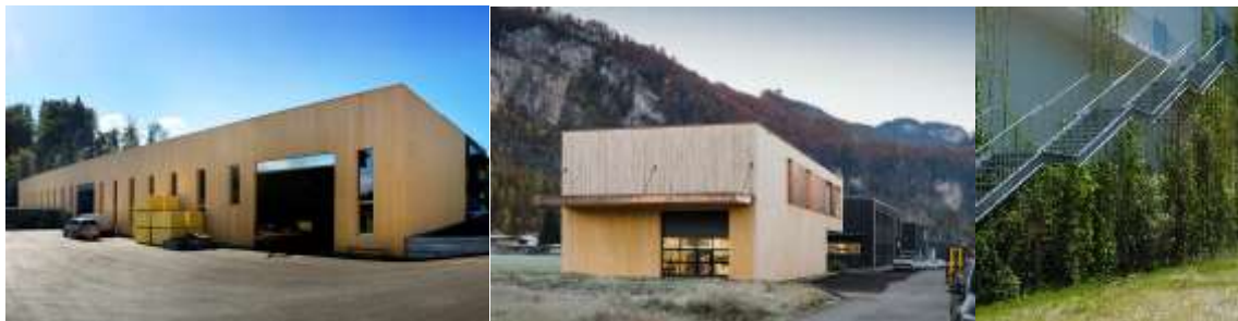
Abb. 3 Beispielfotos für Fassadengestaltungen mit Holz oder rankenden Kletterpflanzen.
